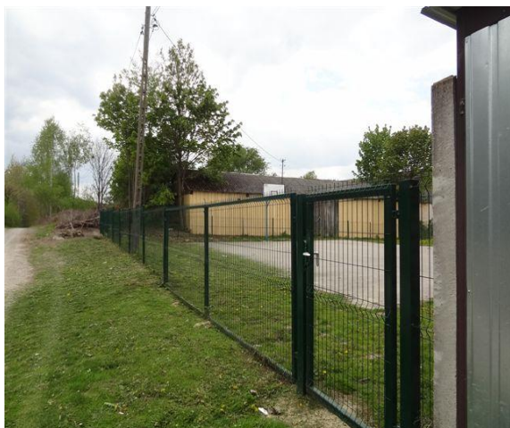
Zdjęcie Nr 12. Ogrodzenie przy SP w Jeleniowie
