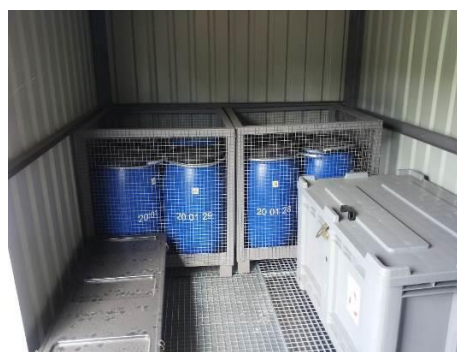
Fot. 8. Wyposażenie kontenera na odpady niebezpieczne – beczki do przechowywania płynnych substancji niebezpiecznych, stalowe kosze mogą służyć do przechowywania drobnego sprzętu elektrycznego i elektronicznego.
