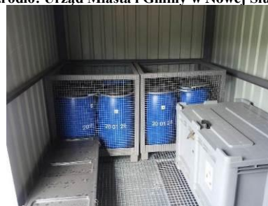
Fot. 12. Wyposażenie kontenera na odpady niebezpieczne – beczki do przechowywania płynnych substancji niebezpiecznych, stalowe kosze mogą służyć do przechowywania drobnego sprzętu elektrycznego i elektronicznego (źródło: Urząd Miasta i Gminy w Nowej Słupii).
