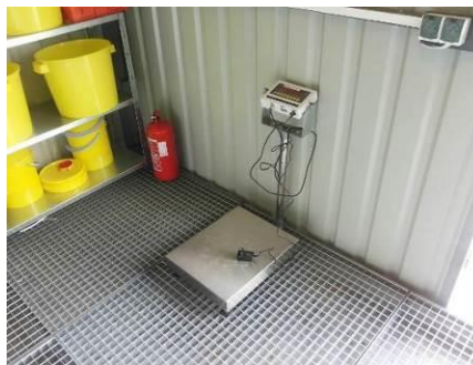
Fot. 10. Wyposażenie kontenera na odpady niebezpieczne - waga z zakresem ważenia do 150 kg (źródło: Urząd Miasta i Gminy w Nowej Słupii).
