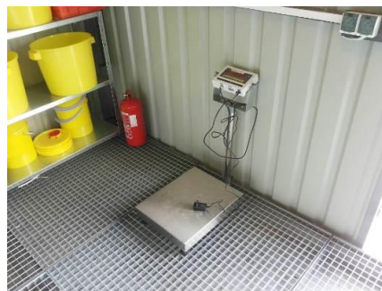
Fot. 6. Wyposażenie kontenera na odpady niebezpieczne - waga z zakresem ważenia do 150 kg (fot. M. Jasiak).
