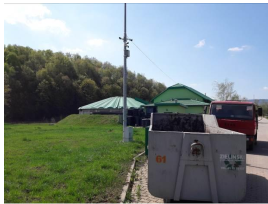
Fot. 12. Kamery monitoringu (fot. M. Jasiak).
