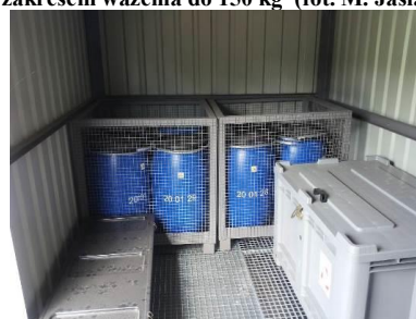
Fot. 8. Wyposażenie kontenera na odpady niebezpieczne – beczki do przechowywania płynnych substancji niebezpiecznych, stalowe kosze mogą służyć do przechowywania drobnego sprzętu elektrycznego i elektronicznego (fot. M. Jasiak).
