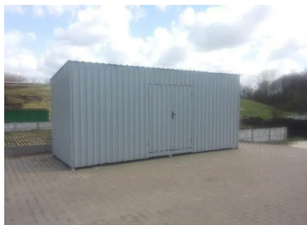
Fot. 5. Kontener na odpady niebezpieczne - 30 m 3 .
