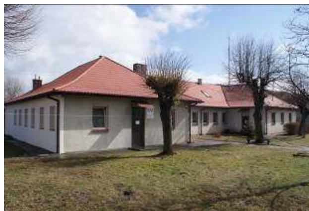
Ośrodek Zdrowia – elewacja zachodnia (frontowa)
