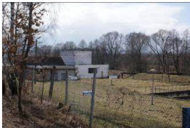
Stacja uzdatniania wody
