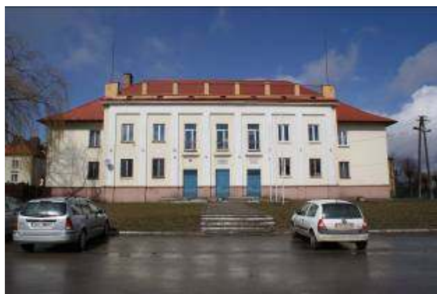
Budynek GOK – elewacja frontowa (południowa)
