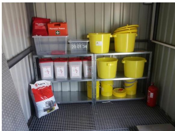
Fot. 7. Wyposażenie kontenera na odpady niebezpieczne - apteczka, koc gaśniczy, gaśnica, sorbent, pojemniki na przeterminowane leki oraz jednorazowe pojemniki na substancje niebezpieczne i chemikalia.
