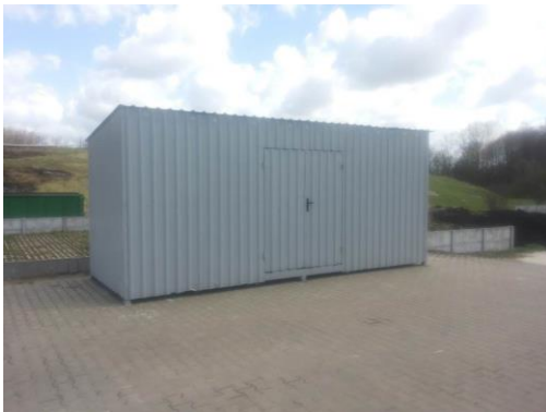
Fot. 5. Kontener na odpady niebezpieczne - 30 m 3 .
